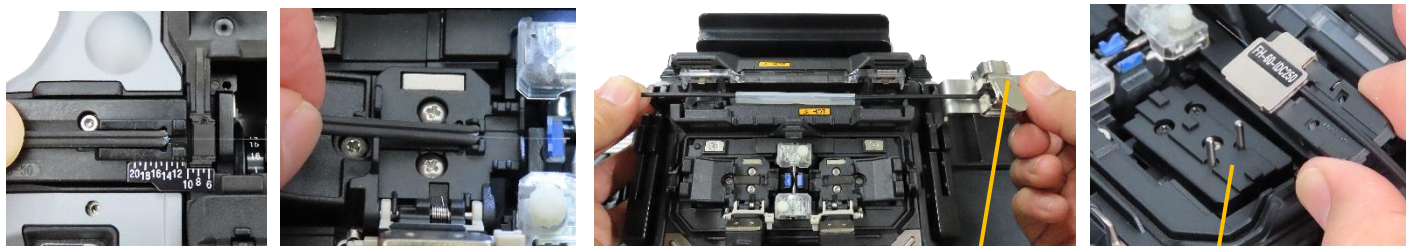
ドロップケーブル接続
