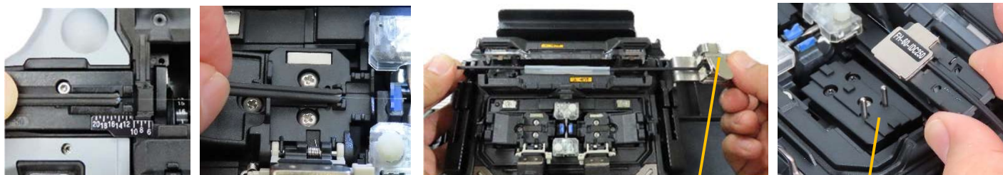
ドロップケーブル接続
